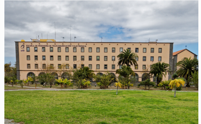
Pabellón B del Edificio de Telecomunicación
