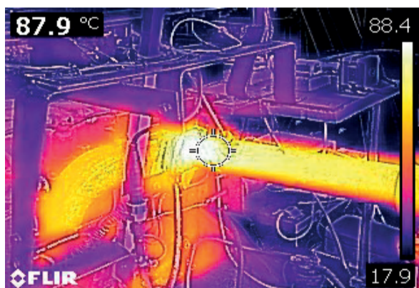
Mediciones con cámara termográfica
