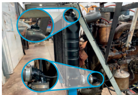
Sensores de temperatura entrada y salida radiador
