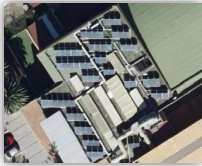
Solar térmica preexistente
