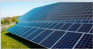
Para la producción de la electricidad, se va a contar con una planta fotovoltaica de 2,5 MW de potencia, consiguiéndose gracias a la disposición de 4.680 paneles solares de 540 W de potencia cada uno.
